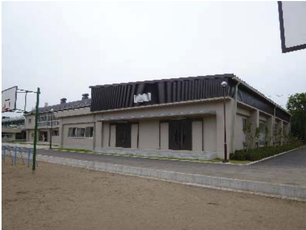
附属中学校屋内運動場(外観)
