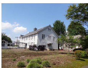
取り壊した石蔵B棟跡地
