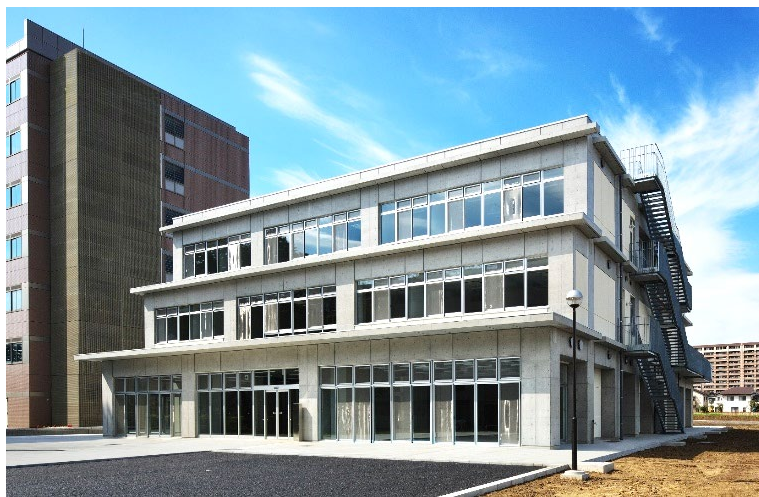
○地域デザイン科学部棟新校舎竣工
